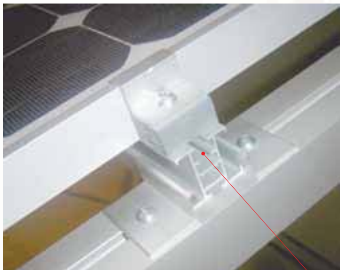
Tuerca guía especial para fijación de perfiles y sujeción de módulos a la estructura
