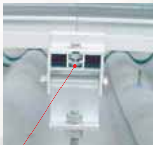
Tuerca guía especial para fijación de perfiles y sujeción de módulos a la estructura
